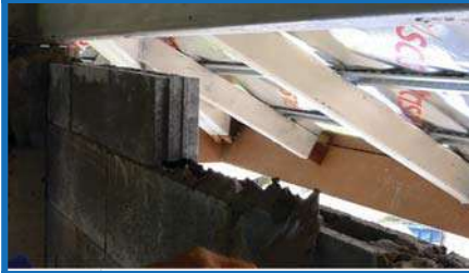
1. ปาดปูนก่อด้านขอบบนของบล็อก
